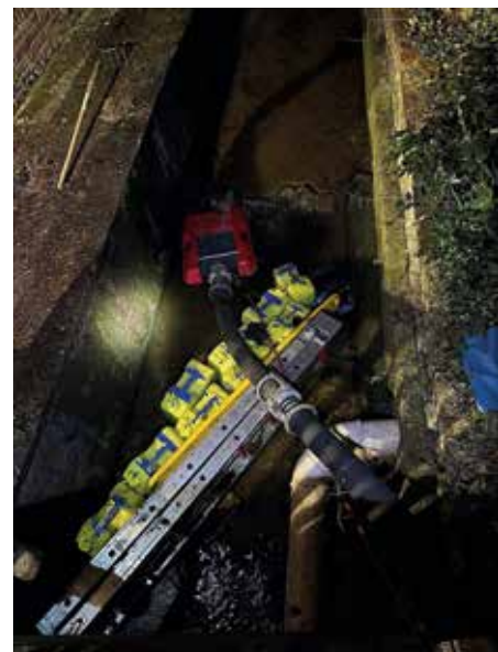
Im dritten Einsatzabschnitt – Wasserversorgung, wurde der Mühlenbach gestaut, um genügend Wasser bereitzustellen.
