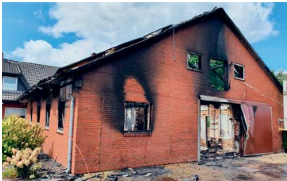
Der hintere Gebäudeteil ist vollständig ausgebrannt. Das Wohnhaus konnte die Feuerwehr schützen.
