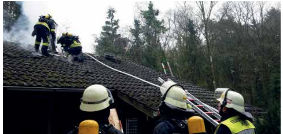
Die Dachisolierung eines Hauses in Hude hat sich durch ein heißes Ofenrohr entzündet.
