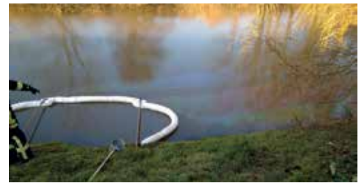
Mit Ölsperren geht die Feuerwehr gegen eine Gewässerverunreinigung auf dem Crildumer Tief vor.
