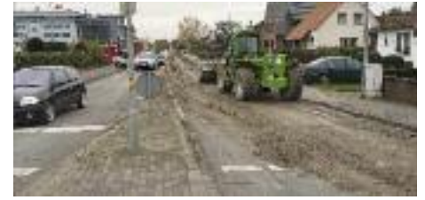
■ Mit Hilfe eines Radladers wurden die groben Verunreinigungen beseitigt.
