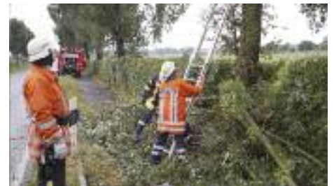
■ Sturmschadenbeseitigung nach heftigem Unwetter.
