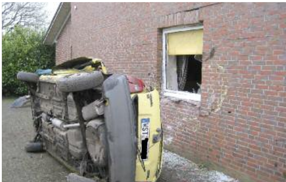
Der Aufprall verursachte an der Klinkerwand des Feuerwehrhauses Mollberg Schäden.
