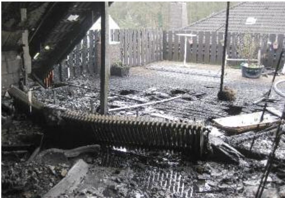
■ Blick aus dem total zerstörten Obergeschoss auf die Dachterrasse.
