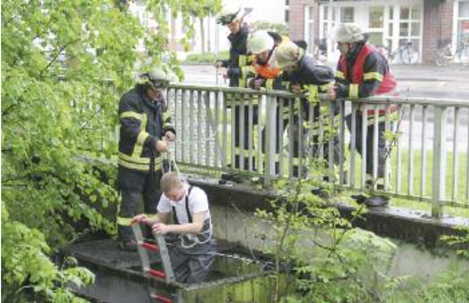
■ Ein Feuerwehrmann stieg, gesichert von seinen Kameraden, in den Schacht.
