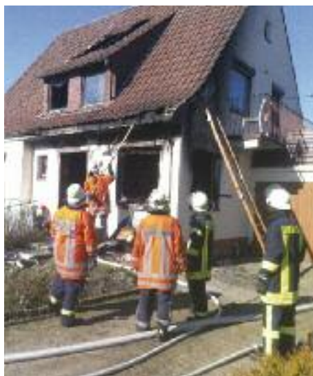
■ Das Wohnhaus war nach dem Brand unbewohnbar.
