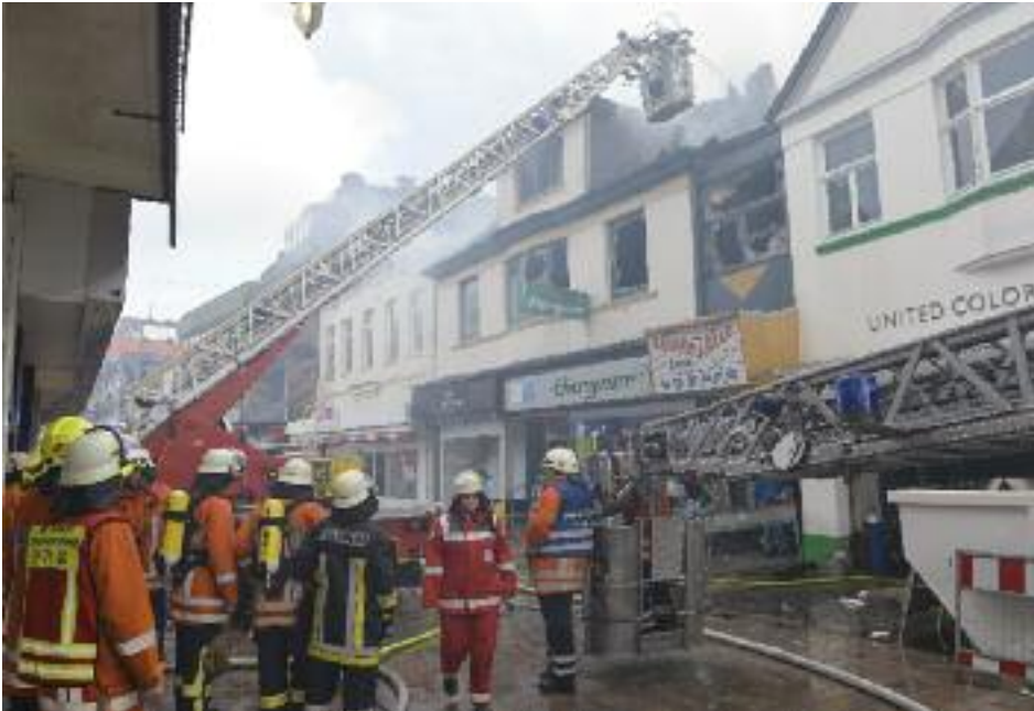
■ Der Blick auf die Einsatzstelle vom Rathausweg aus. Die Anordnung der Häuser ist gut zu erkennen. Links, das Benetton Gebäude mit dem Hinterhaus. Rechts von der Mitte das zerstörte Haus Baro. Das Haus am rechten Bildrand wurde durch Wasser beschädigt.
