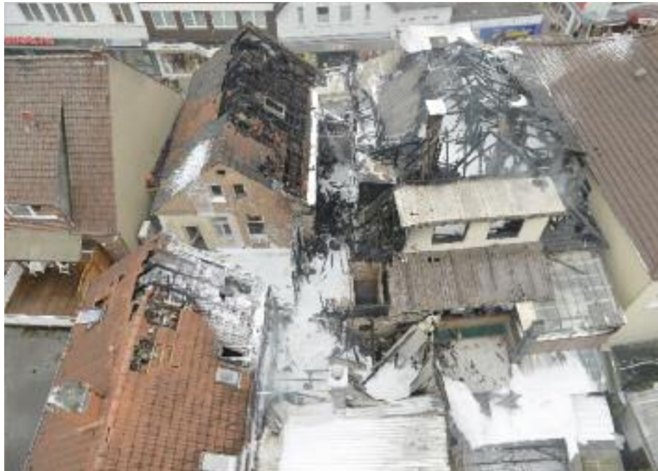
■ Der vollkommen zerstörte Dachstuhl des Hauses Baro aus dem Korb der Drehleiter gesehen.
