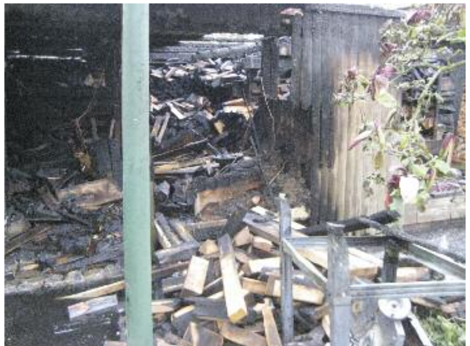
■ Blick in den ausgebrannten Lagerschuppen.
