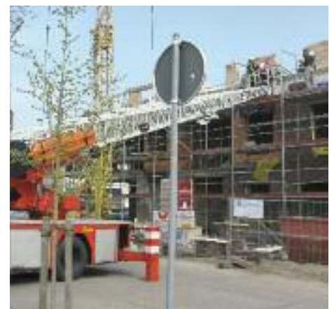
Die Drehleiter wurde für den Transport des schwer verletzten Mannes in Stellung gebracht.
