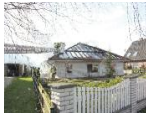
■ Blick auf den völlig zerstörten Bungalow.
