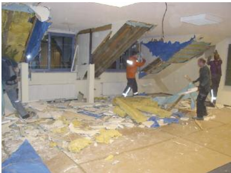
■ Abbrucharbeiten waren für die Kameraden angesagt.
