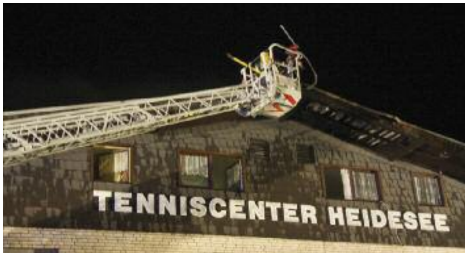
■ Drehleiter in Stellung, rechts die Brandstelle am Dach.
