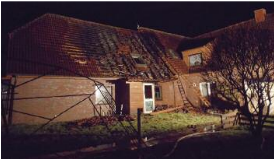
■ Dachpfannen wurden abgenommen um das Feuer löschen zu können.
