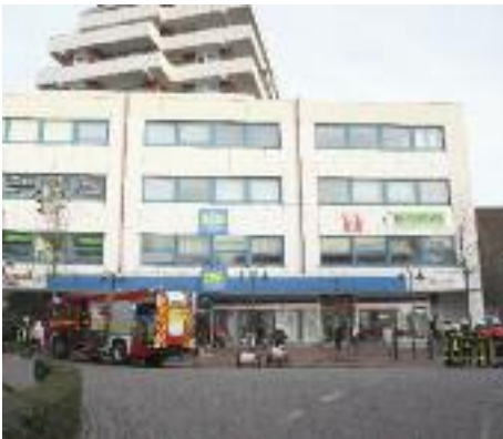
■ Blick auf den Gebäudekomplex.
