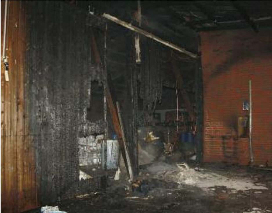
■ Noch rechtzeitig konnten die Feuerwehren eingreifen und größeren Schaden verhindern.
