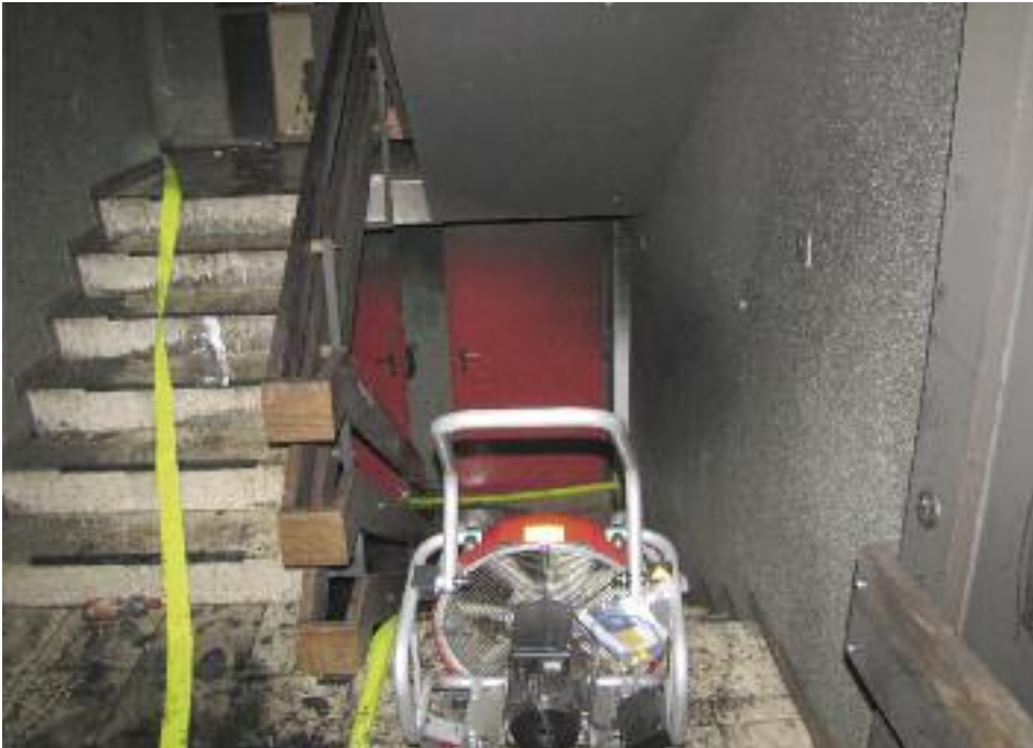
■ Der Überdruckbelüfter sorgte für Frischluft und drängte den Rauch ins Freie. Starke Rußspuren waren im Treppenhaus an den Wänden.
