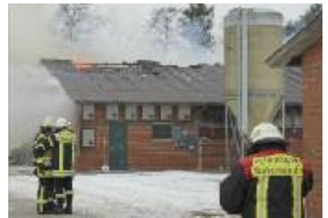
■ Das ca. 80 m lange Gebäude stand im Inneren zum Teil in Flammen.
