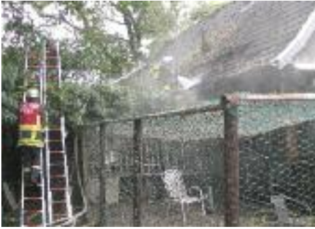
■ Der erste Löschangriff wurde über das Dach vorgenommen.
