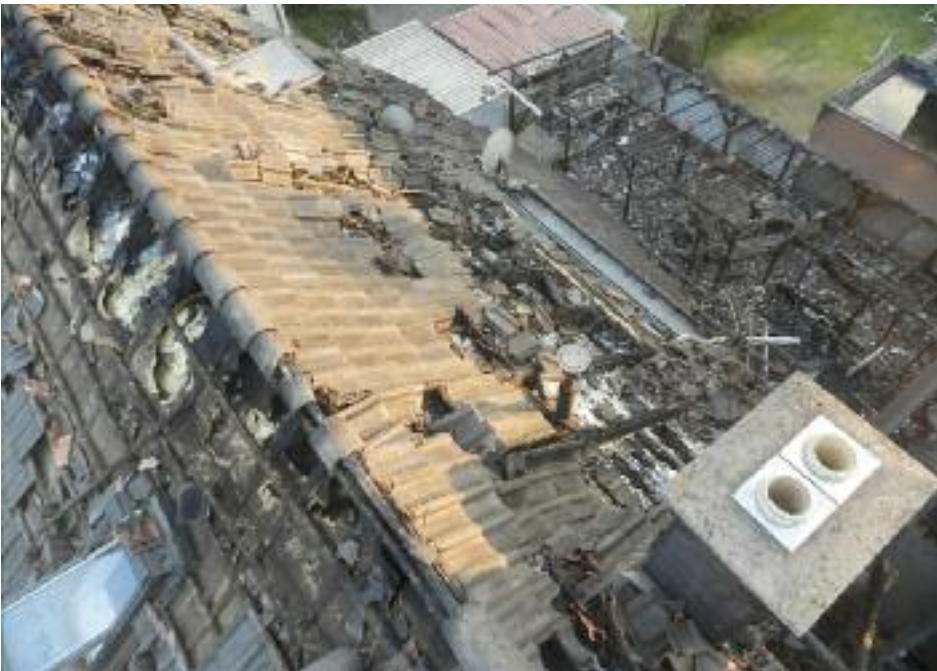
■ Rechts oben am Bildrand der Carport als Ausgangspunkt des Feuers.
