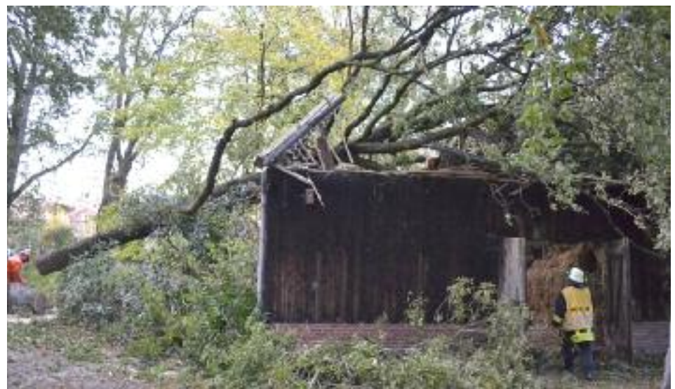
■ Wie hier musste die FF Hude viele Sturmschäden beseitigen.
