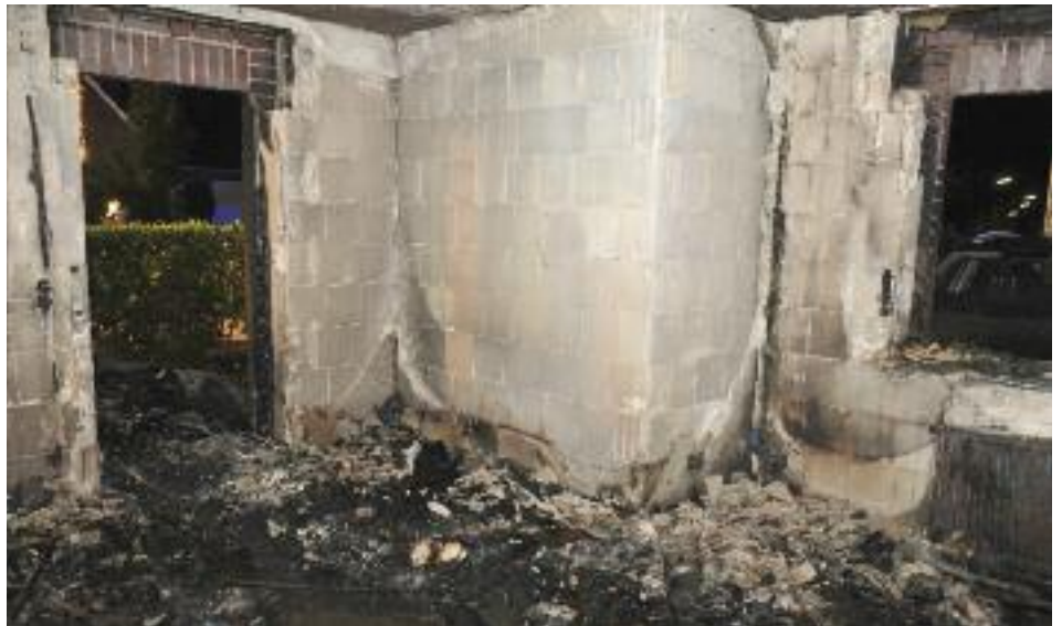
■ Das komplett zerstörte Wohnzimmer. Der von den Wänden gefallene Putz zeugte von der großen Hitze.
